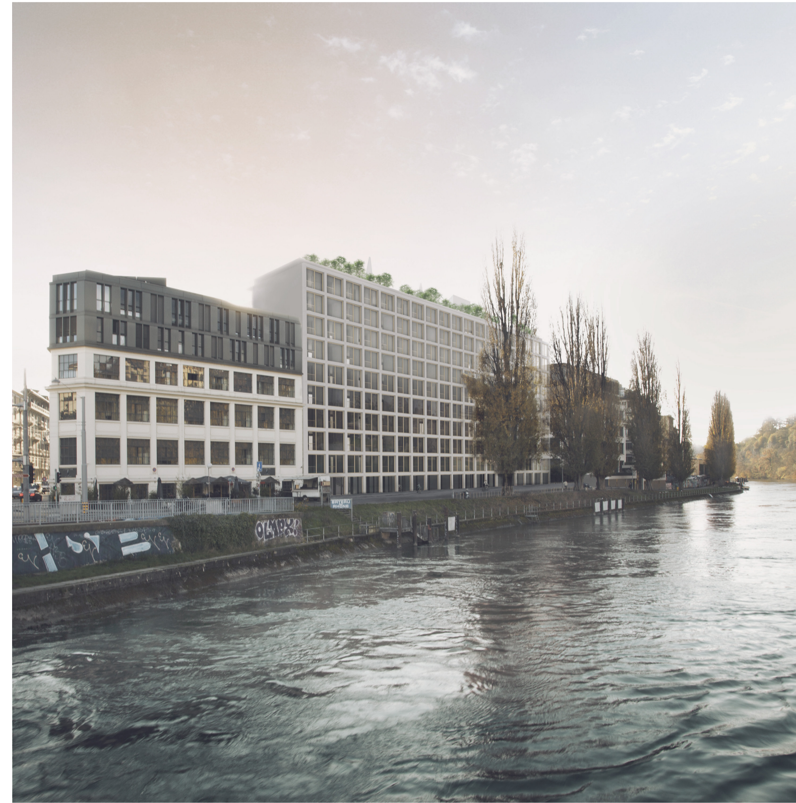
G. vue depuis le pont Sous-terre
