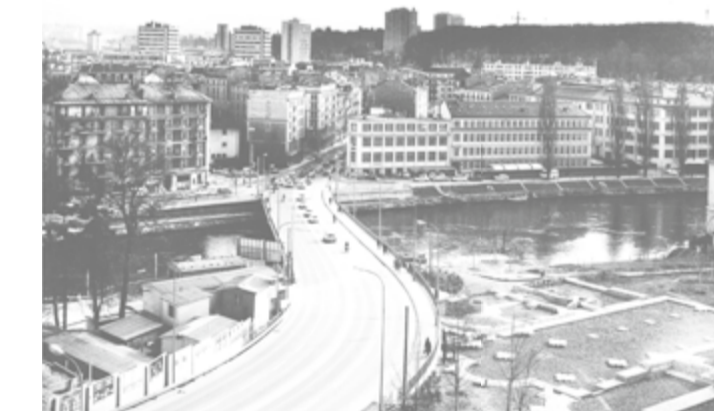
Vue sur le pont sous-terre, 1974
